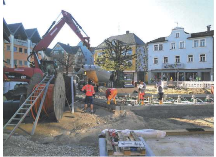
Wallmüllerplatz während der Bauphase
