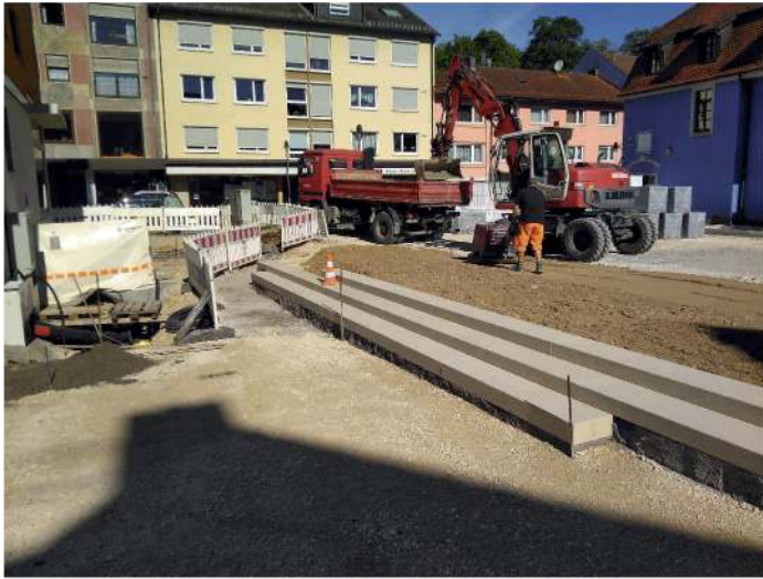
Partnerschaftsplatz während der Bauphase
