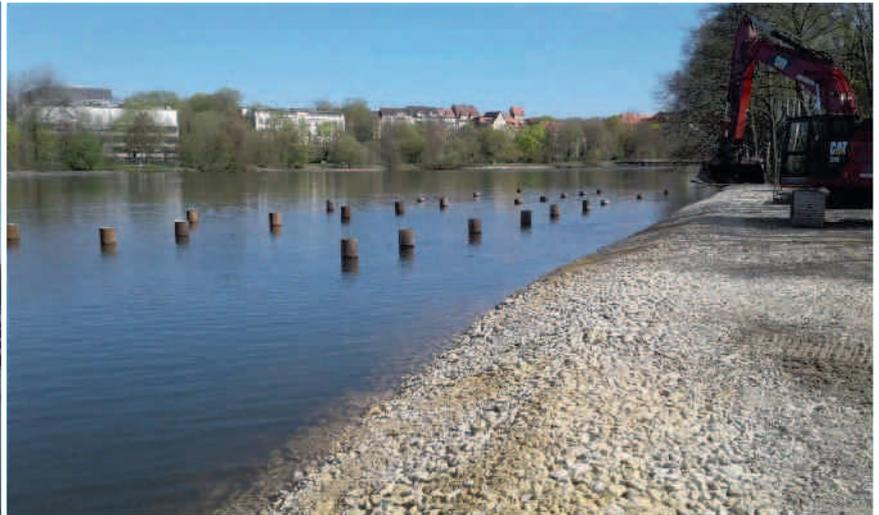
Bild links: Einrammen der Stahlrohre 406 / 10 mm, L = 15,0 m auf temporärer Schüttung
